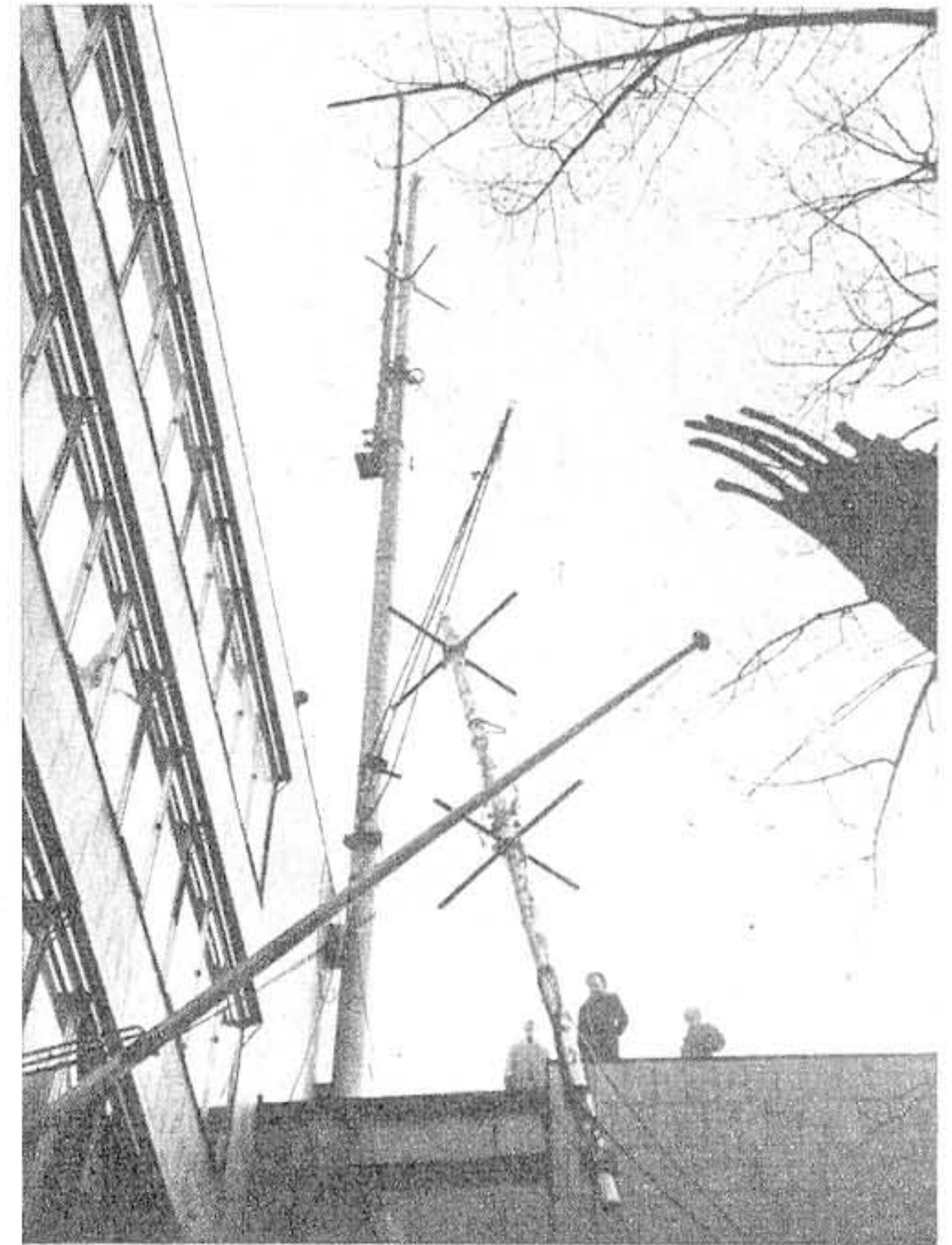
Die neue Fernsehantenne auf der Kopenhagener Technischen Hochschule wird aufgesetzt. Der Kreuzdipol für den Tonsender ist bereits oben. Es folgt der „Doppelquirl“ für den Bildsender
